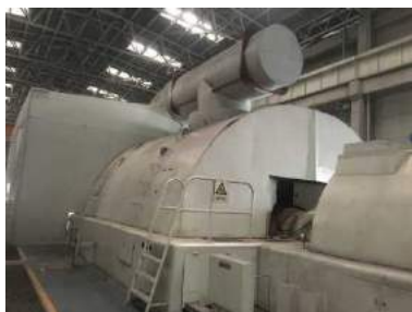
图 2 汽轮机低压缸图
